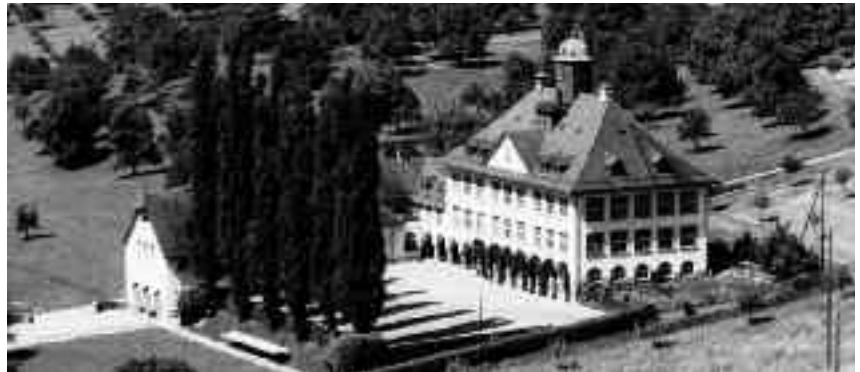
Das Zentralschulhaus in den Vierzigerjahren des letzten Jahrhunderts.
