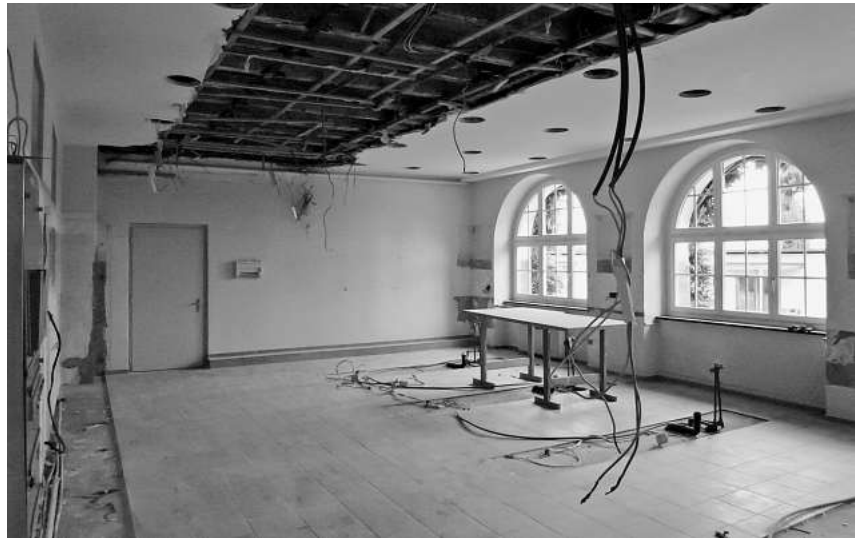
Abbrucharbeiten in der Schulküche.
